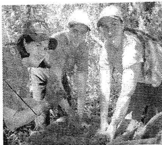
Figura 22 - Mistura do cimento com o solo
