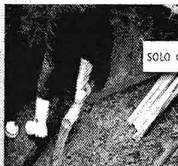
Figura 23 e 24 - Assentamento do cano de 100 mm com solo-cimento
