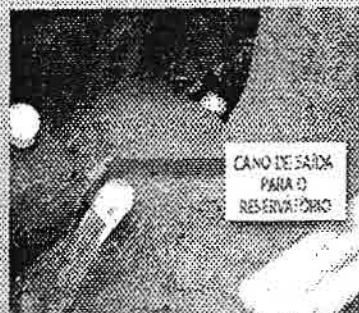
Figura 25 Cano de saída da água para o reservatório ou córrego
