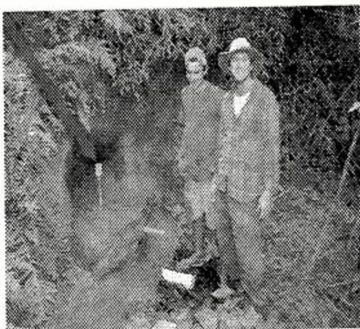
Figura 28 - Nascente pronta com cano de desinfecção instalado.
