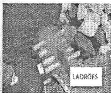
Figura 26 Instalação de canos "ladrões"
