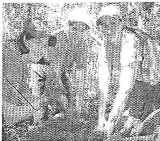
Figura 22 - Mistura do cimento com o solo
