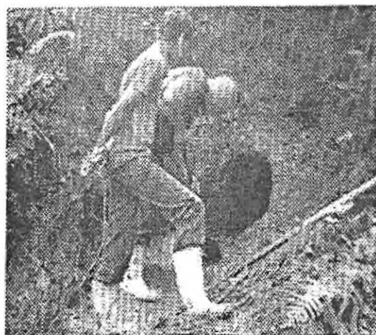
Figuras 20 - Escavações para liberação da nascente
