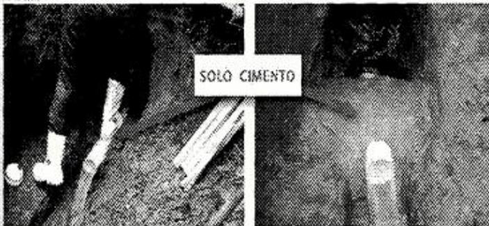
Figura 23 e 24 - Assentamento do cano de 100 mm com solo-cimento
