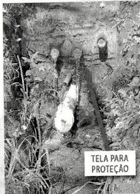
Figura 29 - Nascente pronta com telas de proteção
