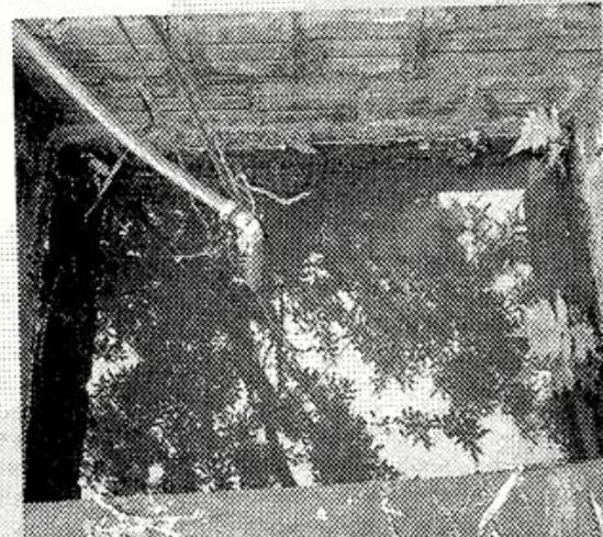
Figura 16 - Captao inadequada em nascente assoreada
