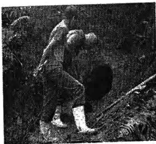
Figuras 20 - Escavações para liberação da nascente
