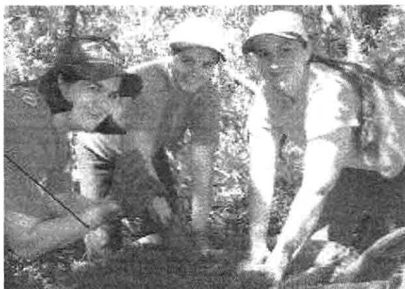
Figura 22 - Mistura do cimento com o solo
