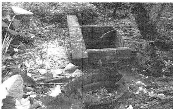
Figura 14 - Sistema antigo de captação
