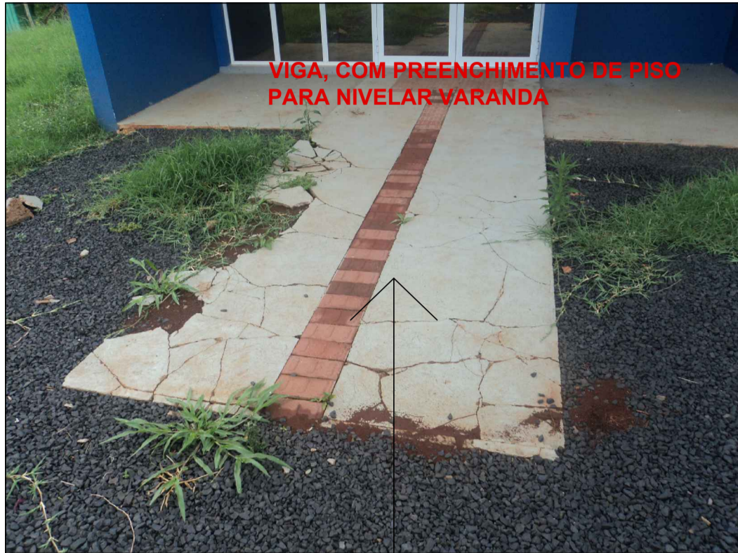
REFAZER RAMPa EM PAVER COM VIGA PARA TRAVAMENTO
