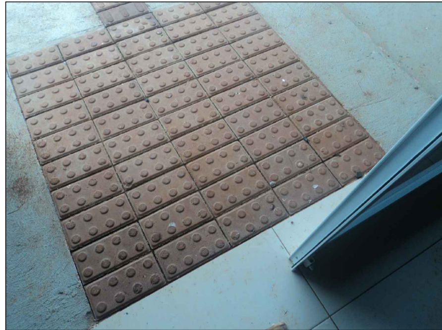
REMOVER PISO TÁTIL EXISTENTE E REASSELTA-LO SOBRE ARGAMASSA
