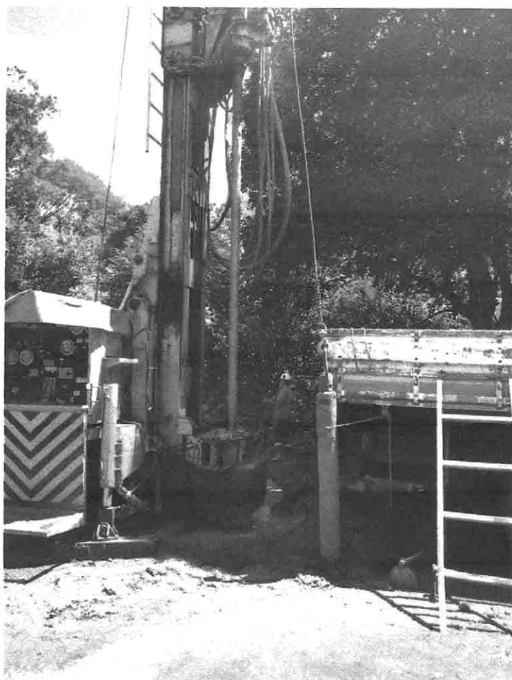
PERFURAÇÃO DO POÇO FEV/2018
