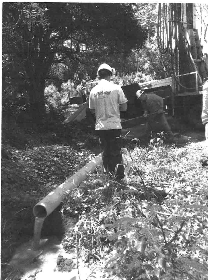
PERFURAÇÃO DO POÇO FEV/2018
