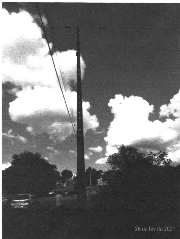
RUA DONA ROSA STÉDILE – VILA NOVA - ALTURA 17,10 METROS
