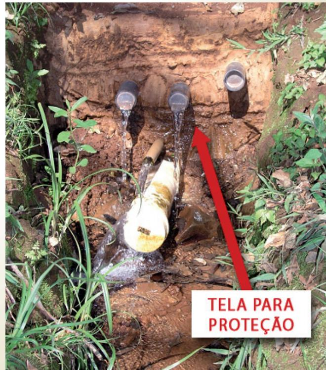
Figura 29 - Nascente pronta com telas de proteção
