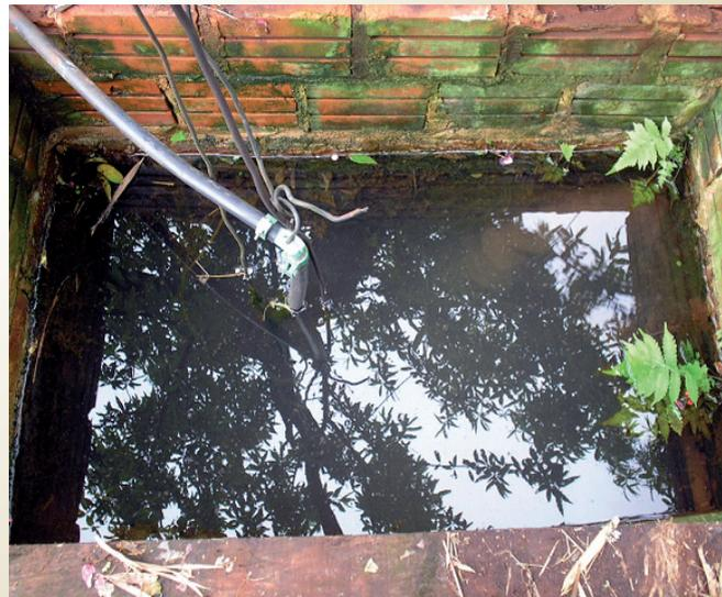
Figura 16 - Captação inadequada em nascente assoreada.
