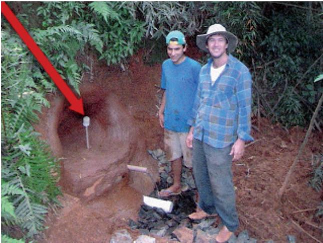
Figura 28 - Nascente pronta com cano de desinfecção instalado.
