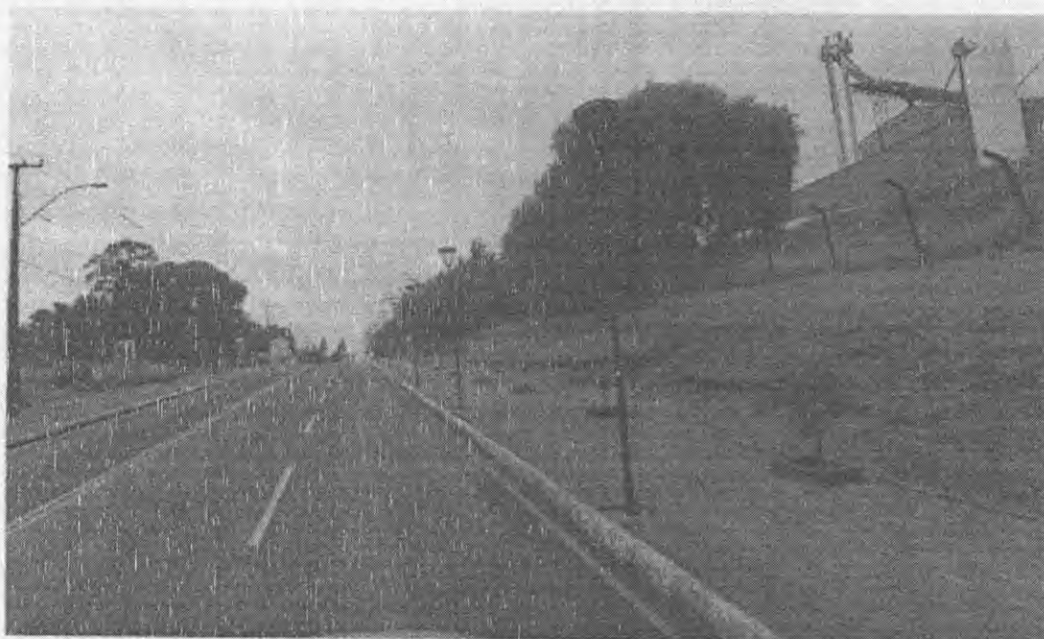
Foto 03: Luminárias na cor preto instaladas na rua Romário Martins, Coronel Vivida.
