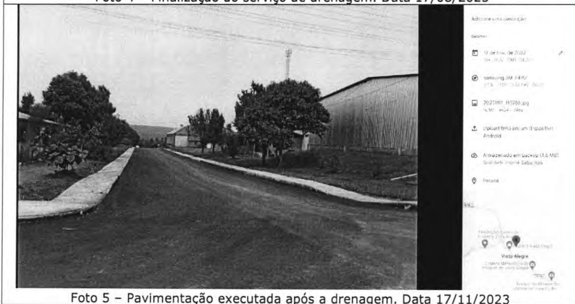
Foto 5 – Pavimentação executada após a drenagem. Data 17/11/2023
