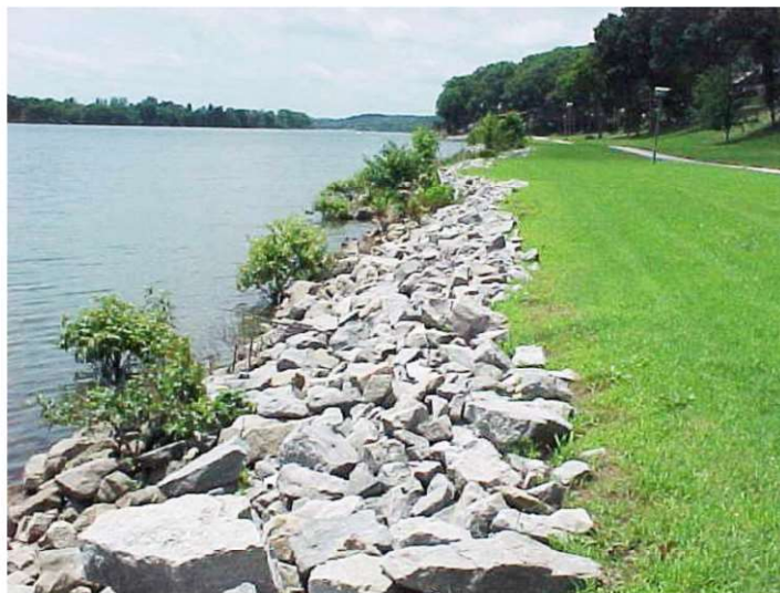
Exemplo de enrocamento
