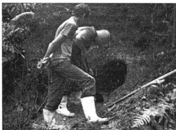
Figuras 20 - Escavações para liberação da nascente
