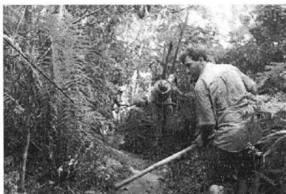
Figuras 18 - Limpeza do local
