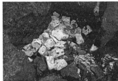
Figura 27 Enchimento da nascente com pedras
