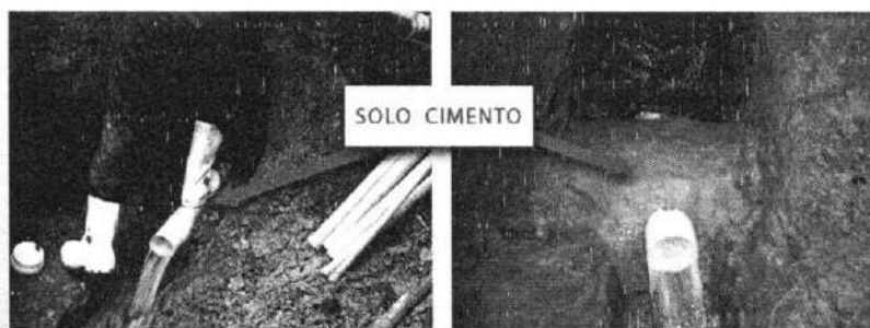
Figura 23 e 24 - Assentamento do cano de 100 mm com solo-cimento
