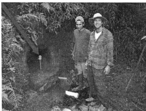
Figura 28 - Nascente pronta com cano de desinfecção instalado.
