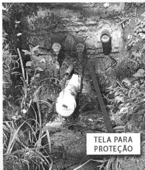
Figura 29 - Nascente pronta com telas de proteção
