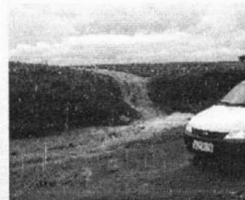
Figura 5 - Enxurrada destruindo estrada
