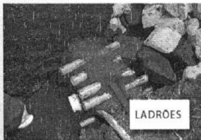
Figura 26 Instalação de canos "ladrões"
