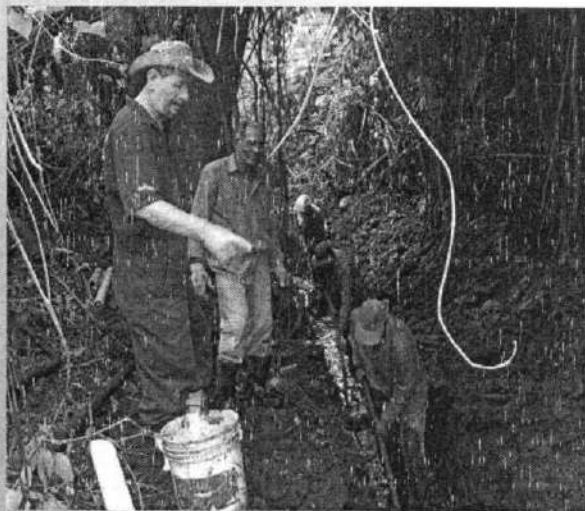
Figuras 17 - Limpeza do local
