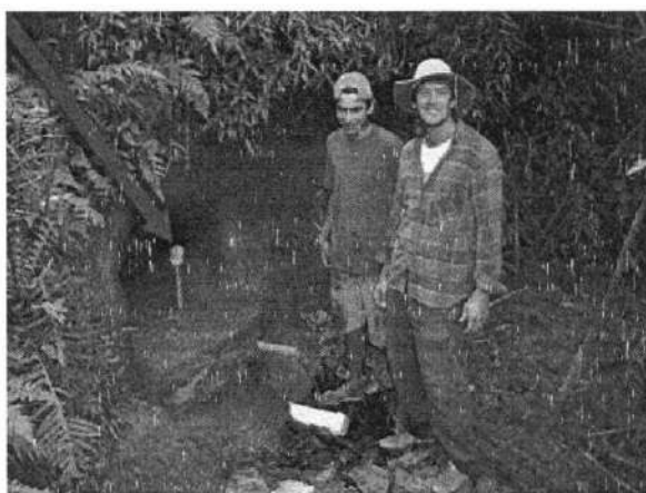
Figura 28 - Nascente pronta com cano de desinfecção instalado.
