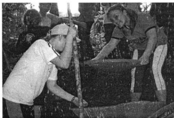
Figura 21 - Peneiramento do solo
