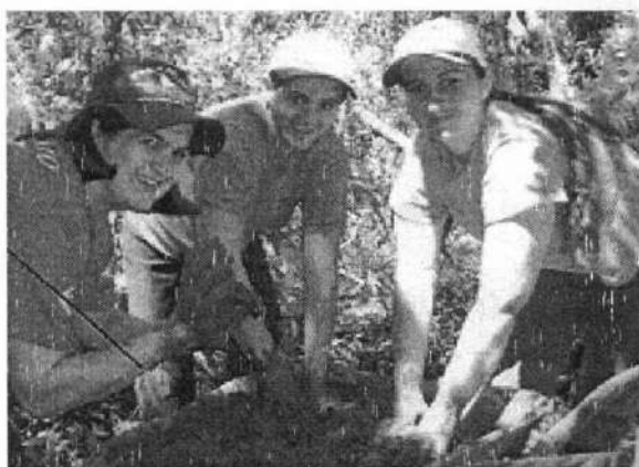
Figura 22 - Mistura do cimento com o solo
