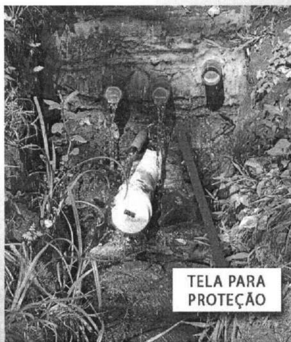
Figura 29 - Nascente pronta com telas de proteção
