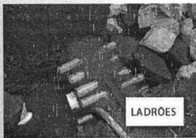
Figura 26 Instalação de canos "ladrões"
