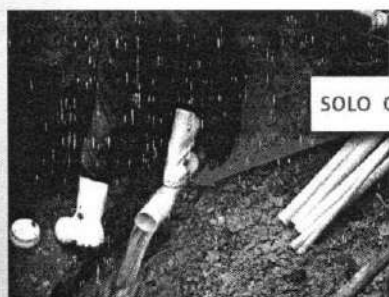
Figura 23 e 24 - Assentamento do cano de 100 mm com solo-cimento
