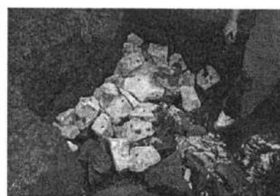
Figura 27 Enchimento da nascente com pedras
