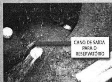
Figura 25 Cano de saída da água para o reservatório ou córrego
