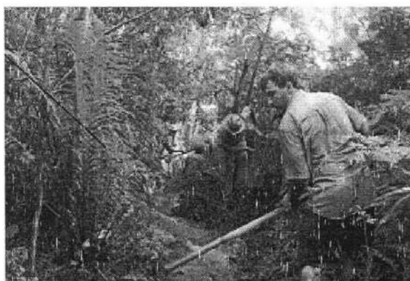
Figuras 18 - Limpeza do local
