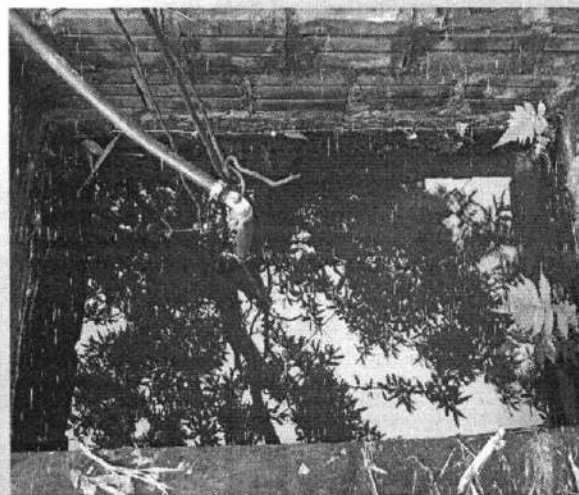
Figura 16 - Captação inadequada em nascente assoreada.
