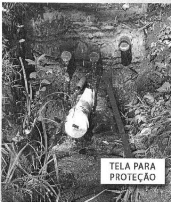
Figura 29 - Nascente pronta com telas de proteção
