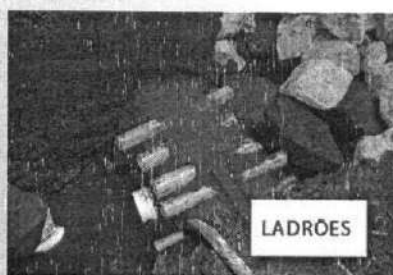
Figura 26 Instalação de canos "ladrões"
