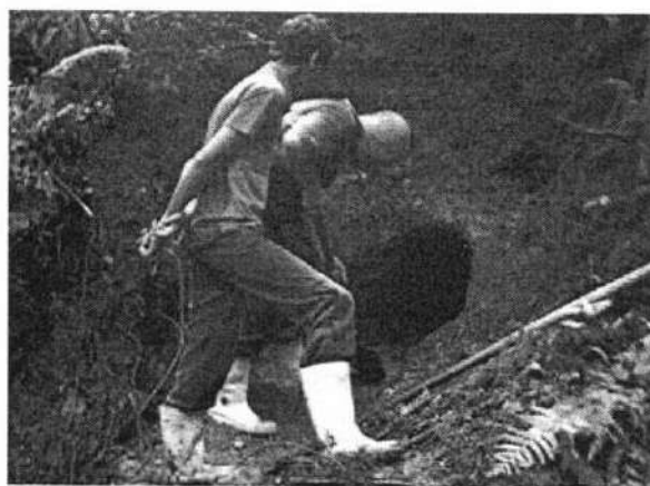
Figuras 20 - Escavações para liberação da nascente
