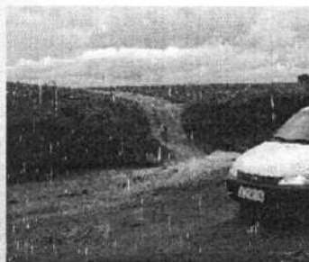
Figura 5 - Enxurrada destruindo estrada
