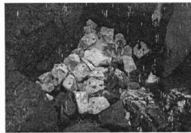
Figura 27 Enchimento da nascente com pedras
