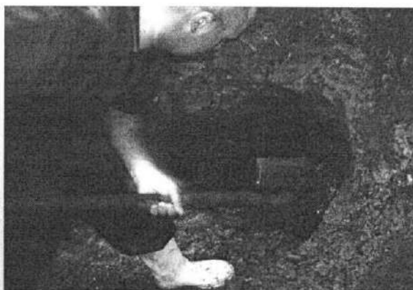
Figuras 19 - Escavações para liberação da nascente
