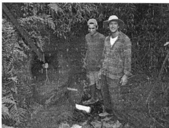
Figura 28 - Nascente pronta com cano de desinfecção instalado.
