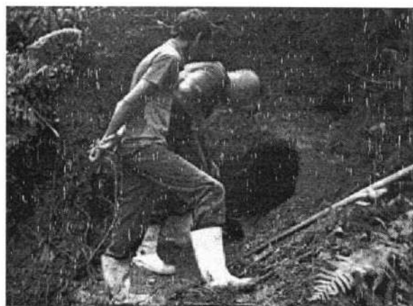
Figuras 20 - Escavações para liberação da nascente
