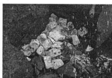
Figura 27 Enchimento da nascente com pedras
