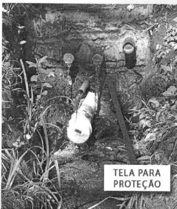
Figura 29 - Nascente pronta com telas de proteção
