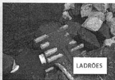
Figura 26 Instalação de canos "ladrões"
