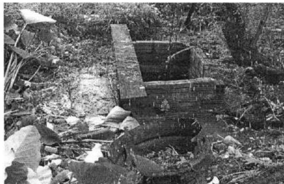
Figura 14 - Sistema antigo de captação
