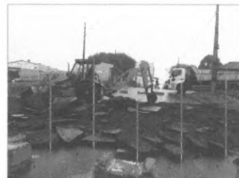
Demolição de Pavimentação Asfáltica
