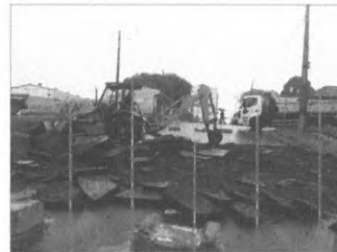
Demolição de Pavimentação Asfáltica
