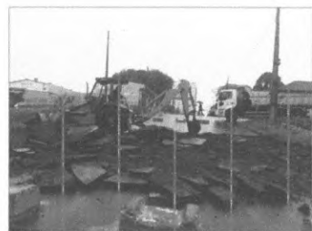
Demolição de Pavimentação Asfáltica
