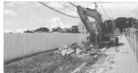
Remoção de Pavimento Intertravado 'Paver'
