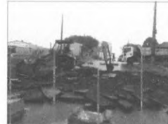
Demolição de Pavimentação Asfáltica
