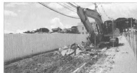
Remoção de Pavimento Intertravado "Paver"
