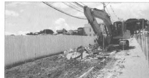
Remoção de Pavimento Intertravado "Paver"
