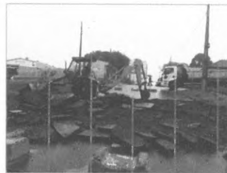
Demolição de Pavimentação Asfáltica
