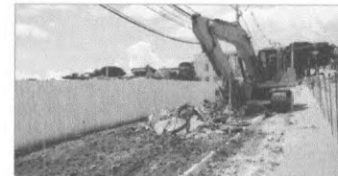
Remoção de Pavimento Intertravado "Paver"
