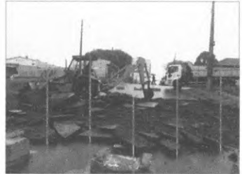
Demolição de Pavimentação Asfáltica
