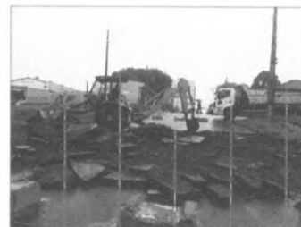
Demolição de Pavimentação Asfáltica
