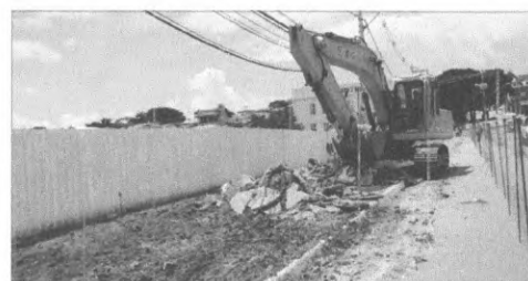
Remoção de Pavimento Intertravado "Paver"
