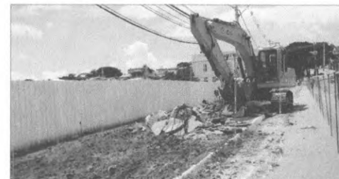
Remoção de Pavimento Intertravado "Paver"
