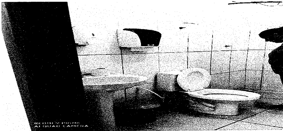
Figura 19 – Reforma de banheiros;
