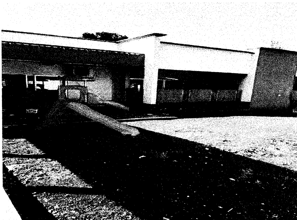
Foto 02: Local para construção do pátio coberto;
