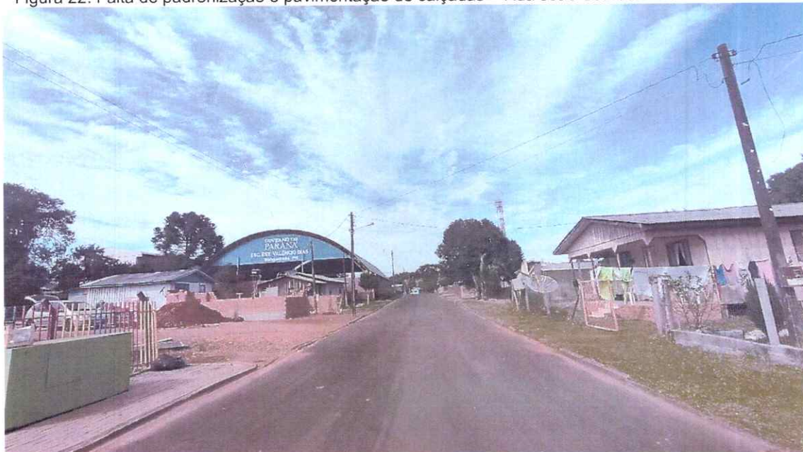
Figura 22. Falta de padronização e pavimentação de calçadas – Rua João Soares Filho – Distrito Covó
